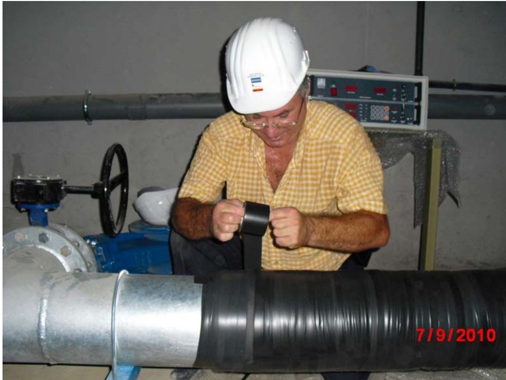
Proceso de aislamiento de los electrodos de transferencia capacitiva
