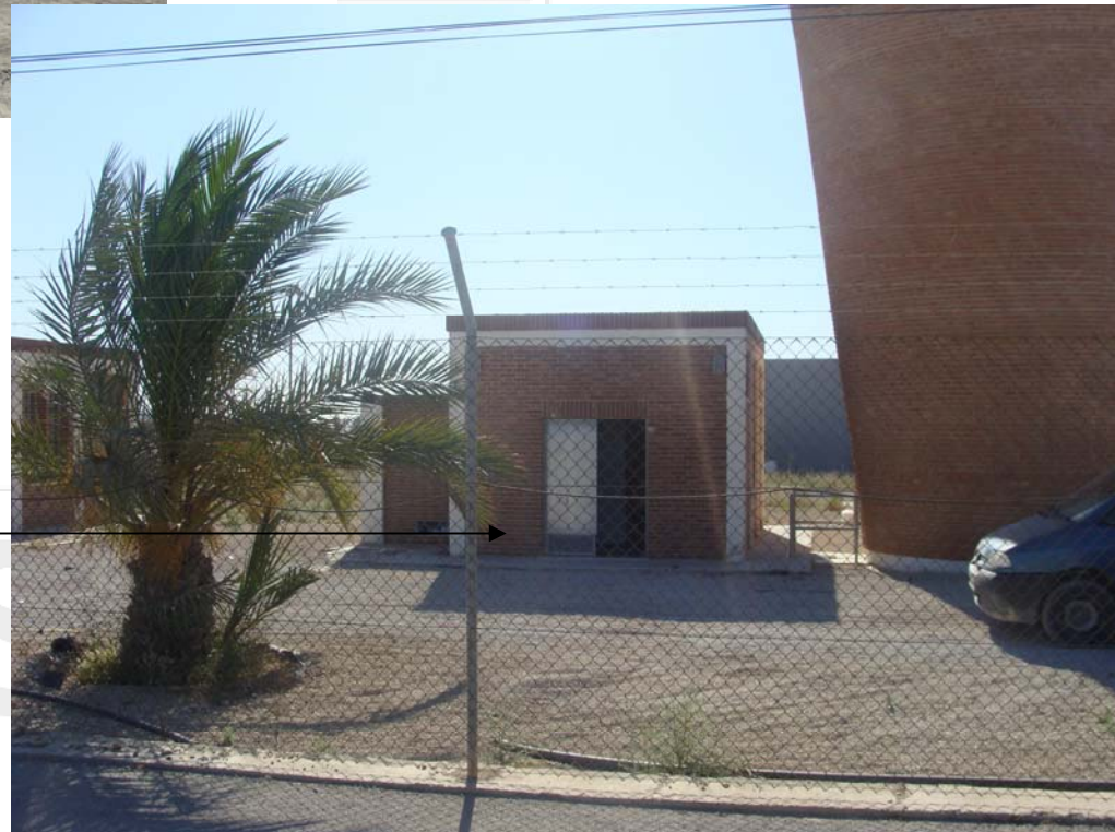
Zona de bombeo y control hidráulico
