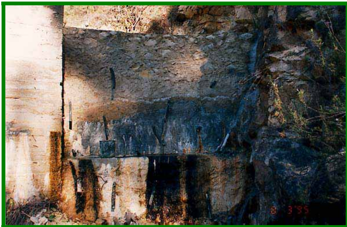
FOTO 16. Represa en el colchón para controlar la inyección de la fuente.
