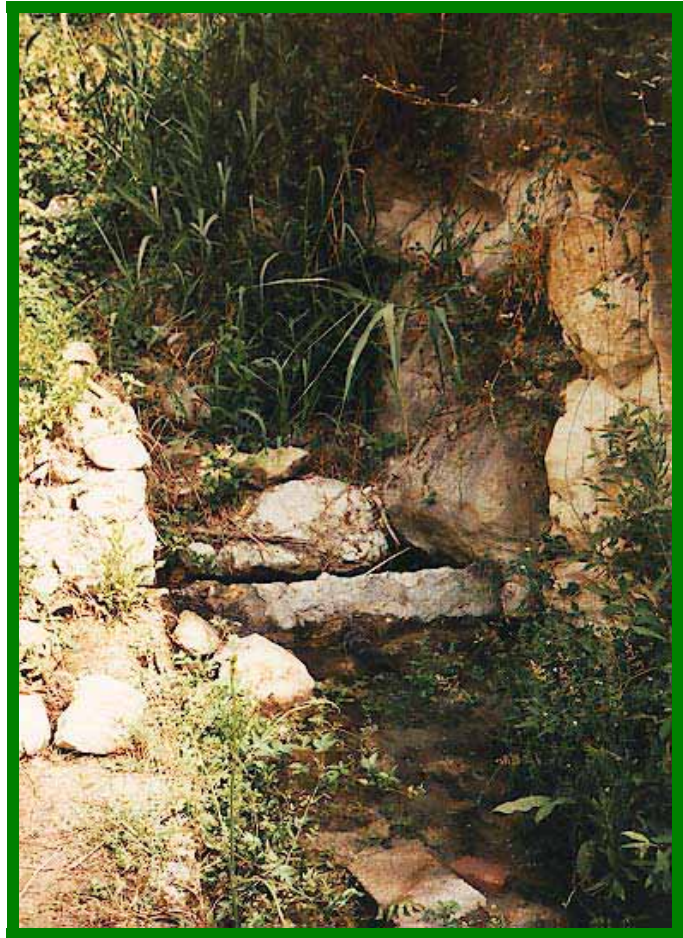
FOTO 12. Tubo aforado en la Fuente de la Higuera
