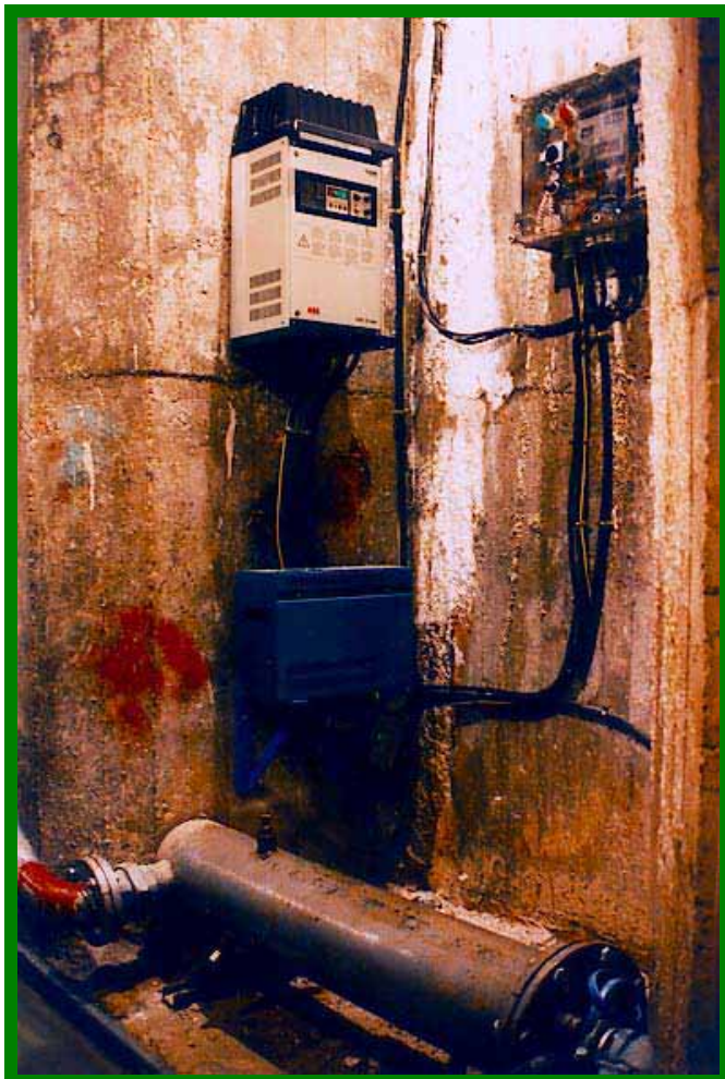
FOTO 8. Instalación de bomba y elementos de control
